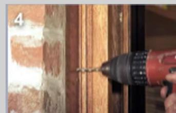
**Dans le cas de la pose C :** les glissières ne sont pas percées, il faut donc les percer avec une mèche à métaux (3 à 4 trous sur la hauteur).
