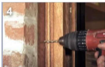
Percer les murs selon les repères et fixer les glissières sur les murs au moyen de vis et de chevilles adaptées au matériau. (non fournies)
