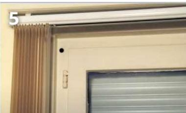
Percer le trou de passage du câble d'alimentation du moteur en face de la sortie de câble sur le volet. Passer le câble et fixer le volet roulant dans les murs.
