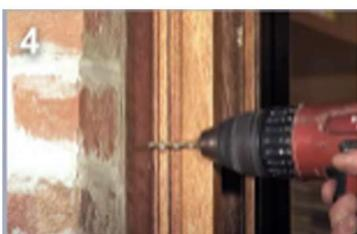
Après avoir repéré l'emplacement des trous de fixation des glissières, percer les murs, puis fixer le volet en place
